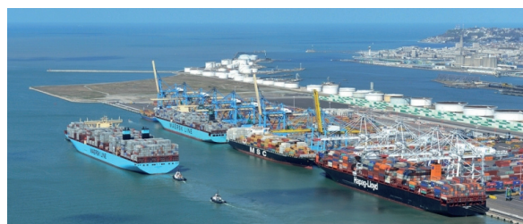
Deux postes restent à construire sur Port 2000 (© GPMH)
